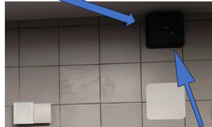
Tranceiver (Antenne Nexeo) Netzwerkkabel (Patchkabel) direkt zum Montageort der Basis
