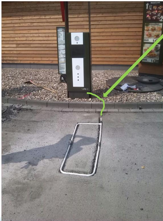
Loop Kabel durch Bordstein in die Säule bzw. Drivefenster einführen (Schutzrohr verwenden)
