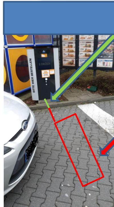
Loop Kabel durch Bordstein in die Säule einführen (Schutzrohr verwenden bitte)
